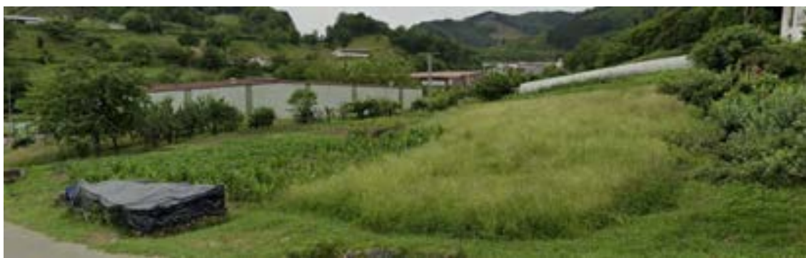
Imagen: aspecto de la zona afectada. Fuente Google maps
