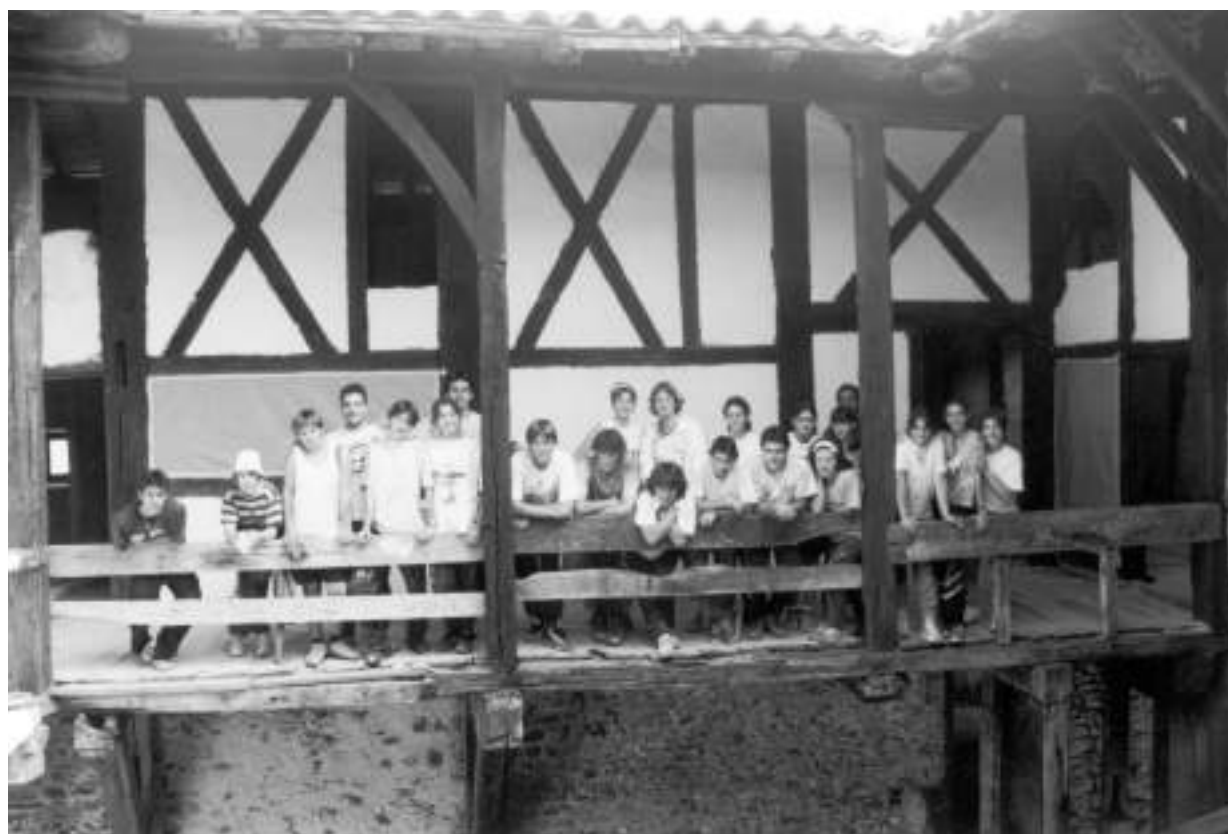
Igartza jauregia. Galeriaren iparraldea zaharberritu eta gero. / Zona norte de la galería después de su recuperación.
