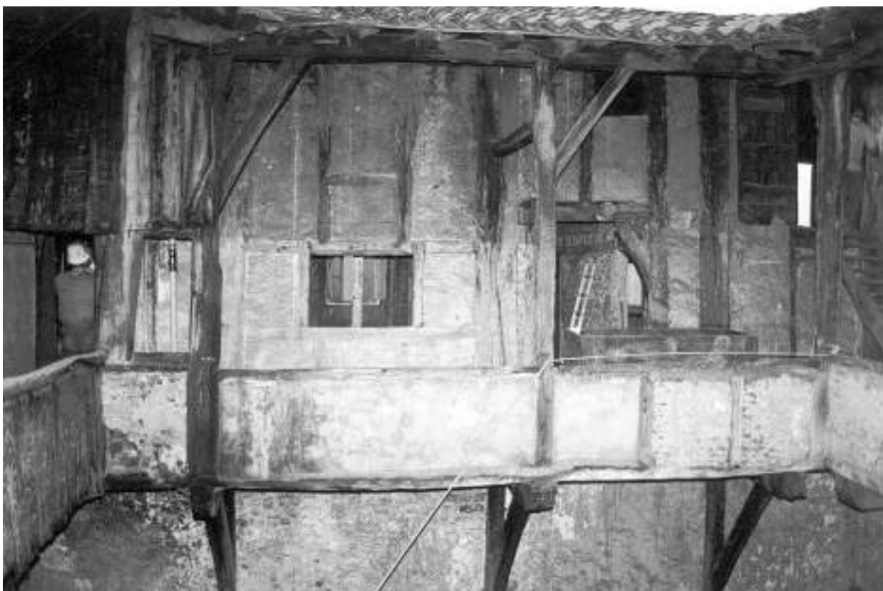
Igartza jauregia. Galeriaren hegoaleda zaharberritu baino lehenago. / Zona sur de la galería antes de su recuperación.
