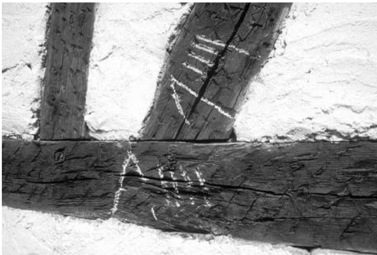
Igartza jauregia. Zurginen markak hegoaldeko fatxadan. Zeheztasuna./ Marcas de carpinteros en la fachada sur. Detalle.
