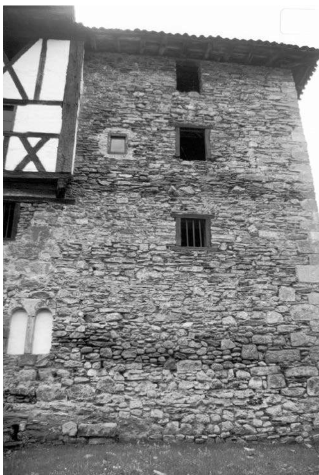
Igartza jauregia. Berreraikitutako iparmendebaldeko zonaldea. Ikus bi harri-egituren arteko ezberdintasuna. / Reconstrucción de la zona noroeste. Obsérvense la diferencia entre los dos aparejos.
