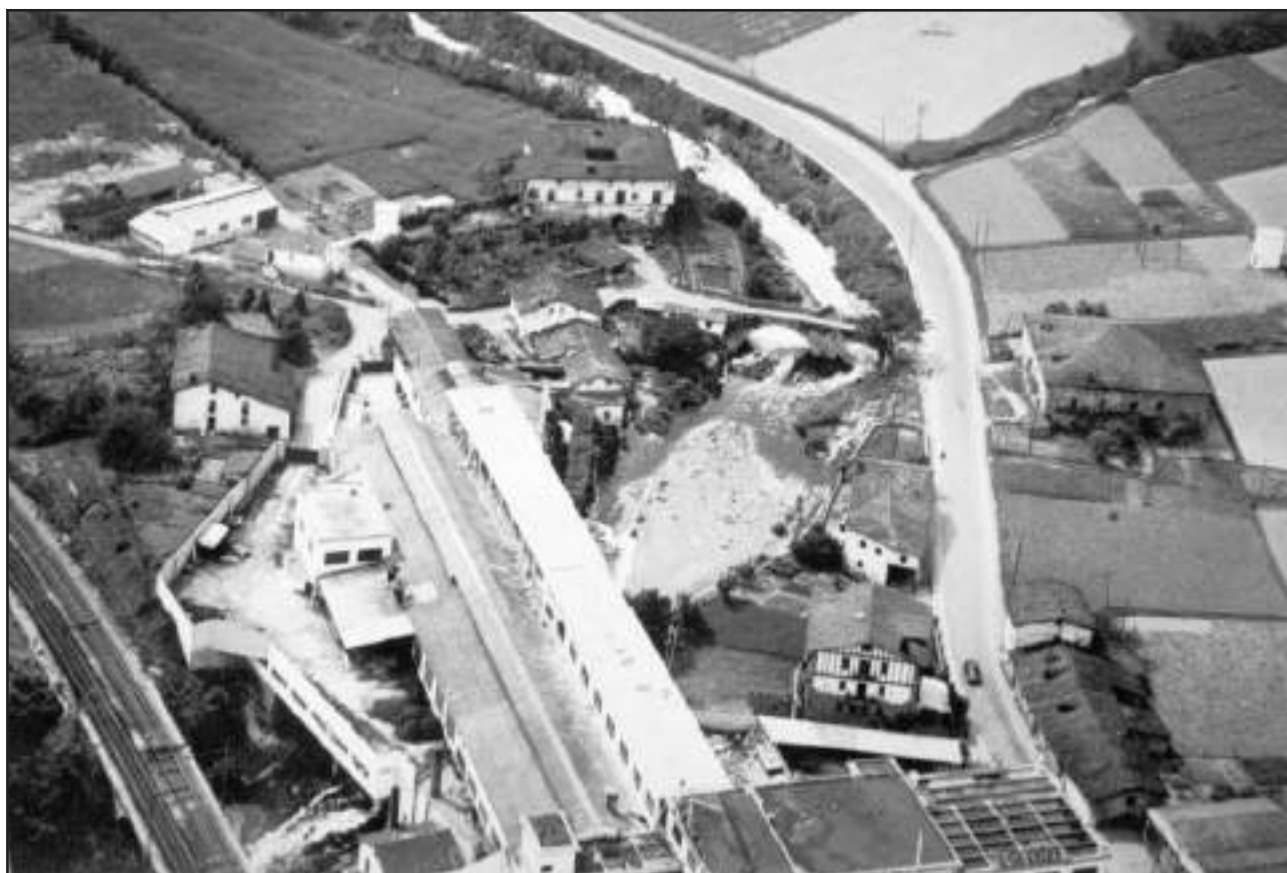
Burdinolaren gainean Indar lantegiaren pabiloiaren eraikuntza. / Construcción del pabellón de la fábrica Indar sobre la ferrería
