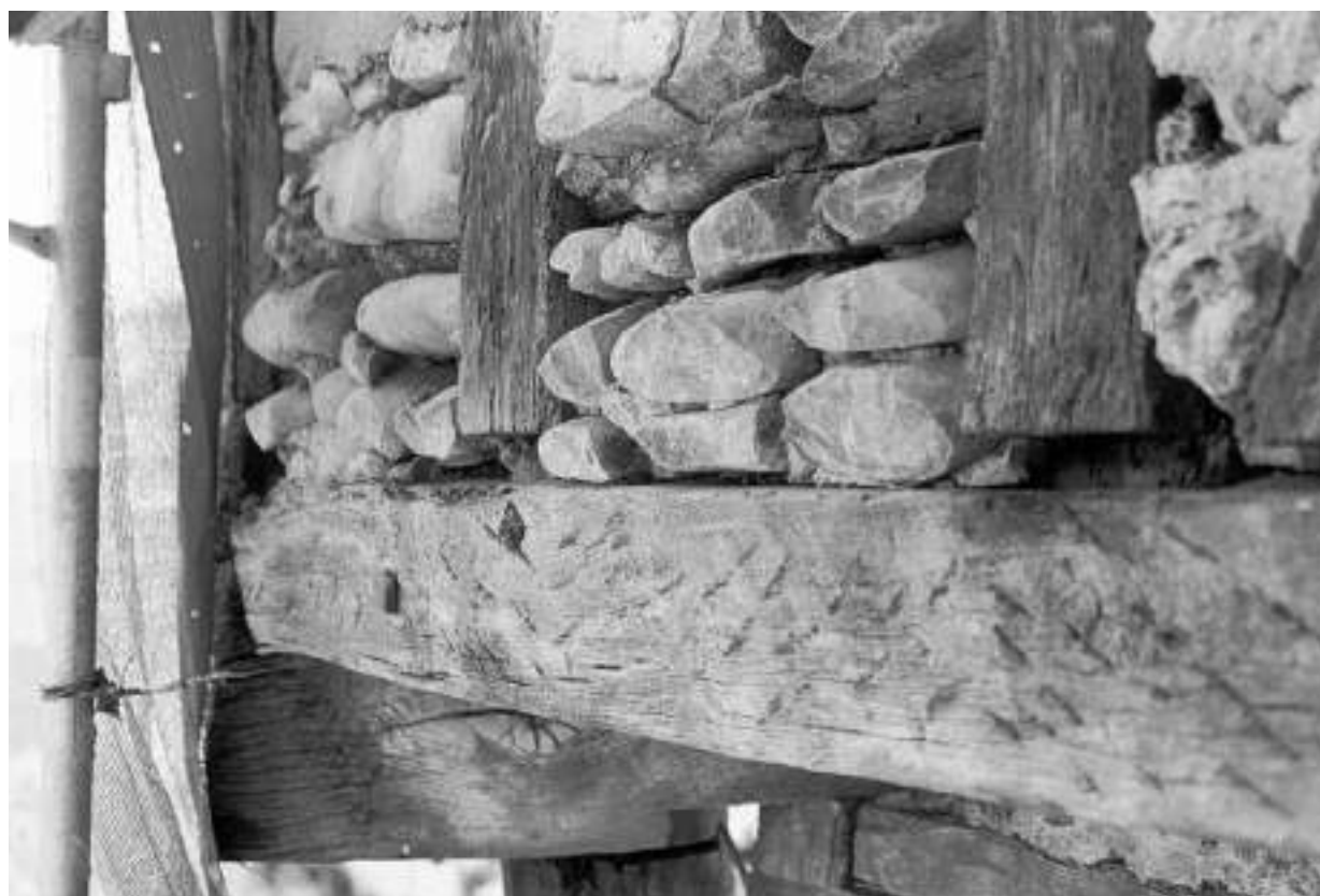
Igartza jauregia Iparraldeko fatxada. Errekaharritzko paretak. Zeheztasuna. / Fachada norte. Paredes hechas con cantos rodados. Detalle.
