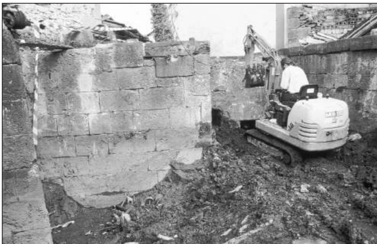
Igartzako Errota. Aldaparoaren garbiketa lanak. / Trabajos de limpieza de la antepara.
