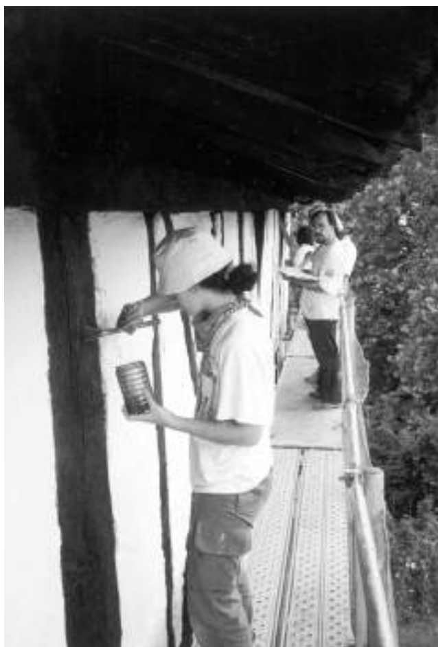
Igartza jauregia. Alfredo Moraza arkeologoak zurezko egituraren dokumentazio lanetan. / El arqueólogo Alfredo Moraza realizando trabajos de documentación de la estructura de madera.
