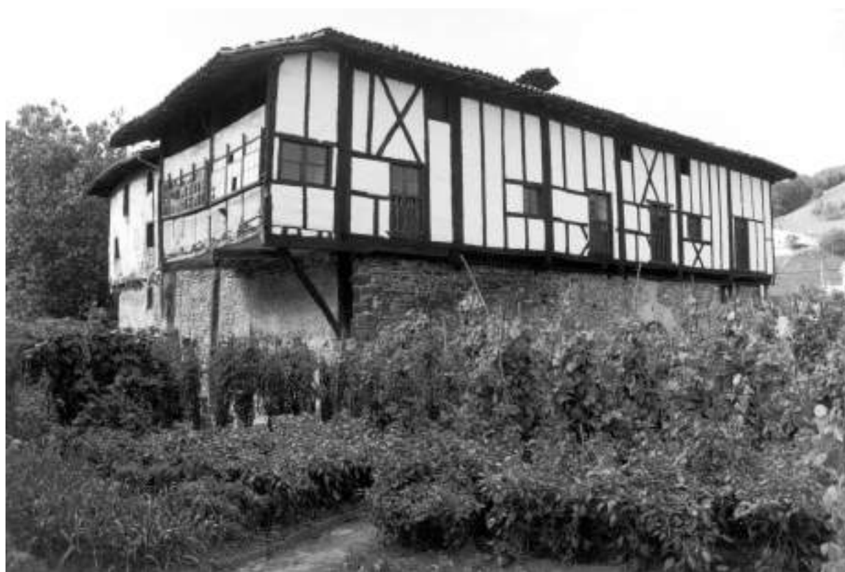
Igartza jauregia. Fatxada nagusia zaharberritu eta gero. / La fachada principal después de su recuperación.
