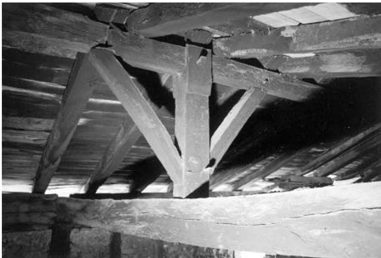
Igartza jauregia. Gailurraren sardego-mihiztadura. / Ensamblaje en quijera de la cumbra o caballete.
