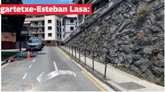
Igartetxe-Esteban Lasa: Asfaltaketa eta espaloia birgaitu / Rehabilitación de la acera y asfaltado
