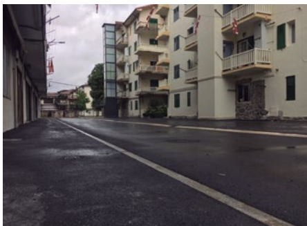
Renovación de la red de servicios y mejora de la accesibilidad unificando la altura de las aceras con la carretera
