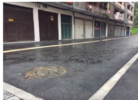
Renovación de la red de servicios y mejora de la accesibilidad unificando la altura de las aceras con la carretera
