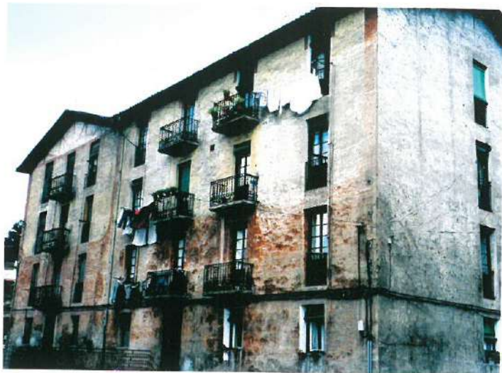
Baserriaren horma nagusietako batzuk erabiliz eraikitako etxea. Casa levantada aprovechando algunas paredes maestras del caserío.
