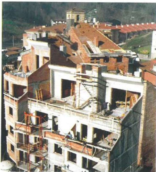
Eraikitzen ari diren etxe berria. Amara, 2003 urtearen erdialdera. Nueva casa de pisos en construcción. Terminación a mediados del año 2003.
