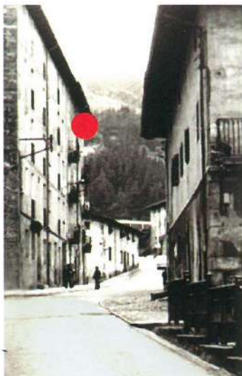
Solairuetako etxea 1983an. La casa de pisos en el año 1983.
