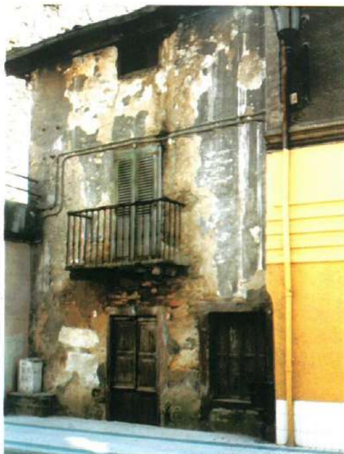
Etxea 2002ko apirilean bota zuten. La casa se derribó en Abril del año 2002.
