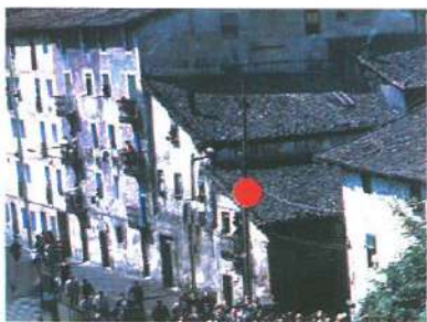
1979an bota zuten, Arane Zaharra baserriaren eskuinaldeko zatiaarekin batera. Se derribó junto con la parte derecha de Arane-zarra en el año 1979.
