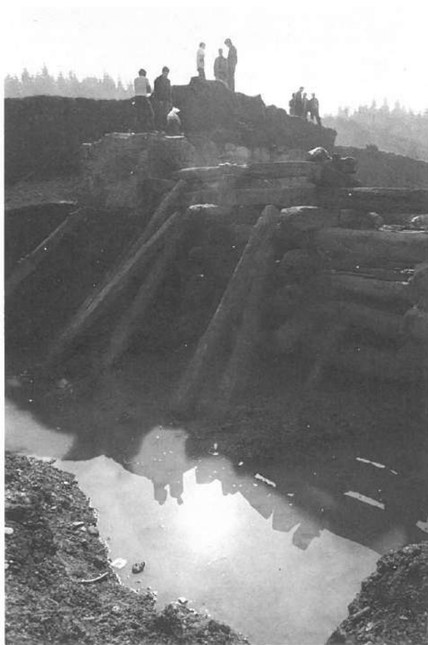
Igartzako burdinola eta errotarako zurezko presa, indusketa lanak egiterakoan. XVI. mendearen erdialdeko zatia datatua da.
