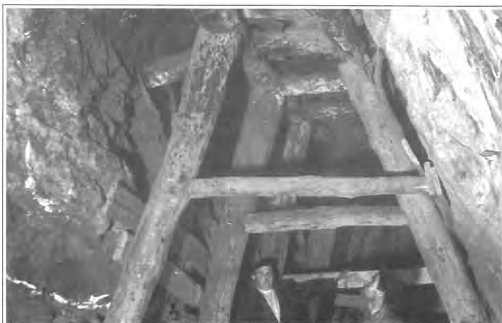
Galería de avance de unos 3'20 m. de altura y entibación con madera.
