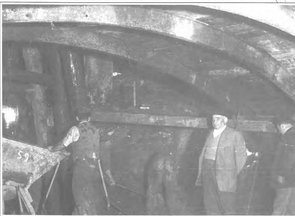
Cerchas metálicas y encofrado de madera.
