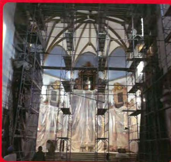
**26**—La Parroquia de la Asunción cerraba sus puertas al culto para acometer la obra de sellado de la gran grieta que recorre bóvedas, muros y solera. Este agrietamiento surgía 3 años antes tras las excavaciones realizadas en un solar próximo.
